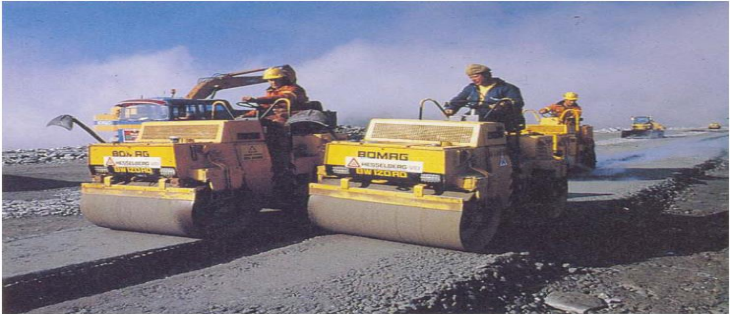
شکل ۴- تراکم هسته و فیلتر اطراف آن توسط غلطک
