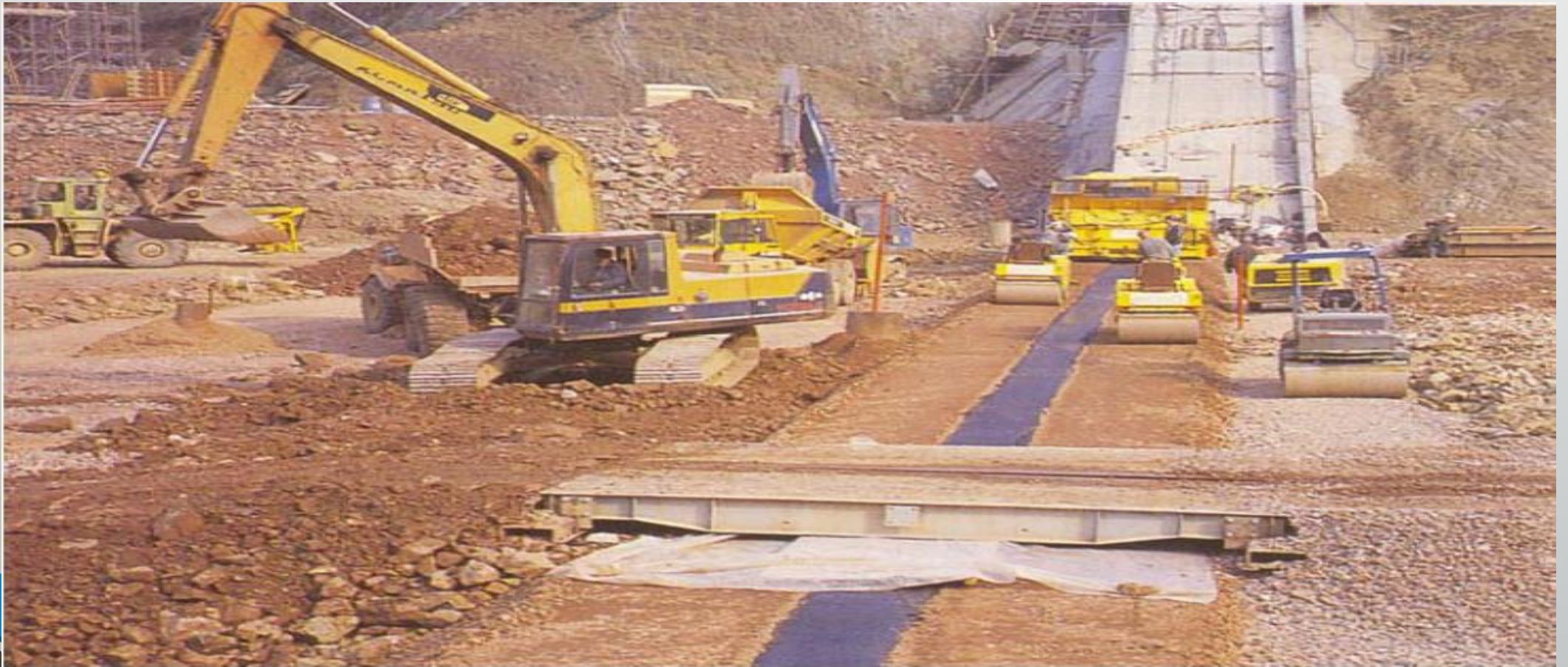
شکل ۸- پل فولادی سبک بر روی هسته
