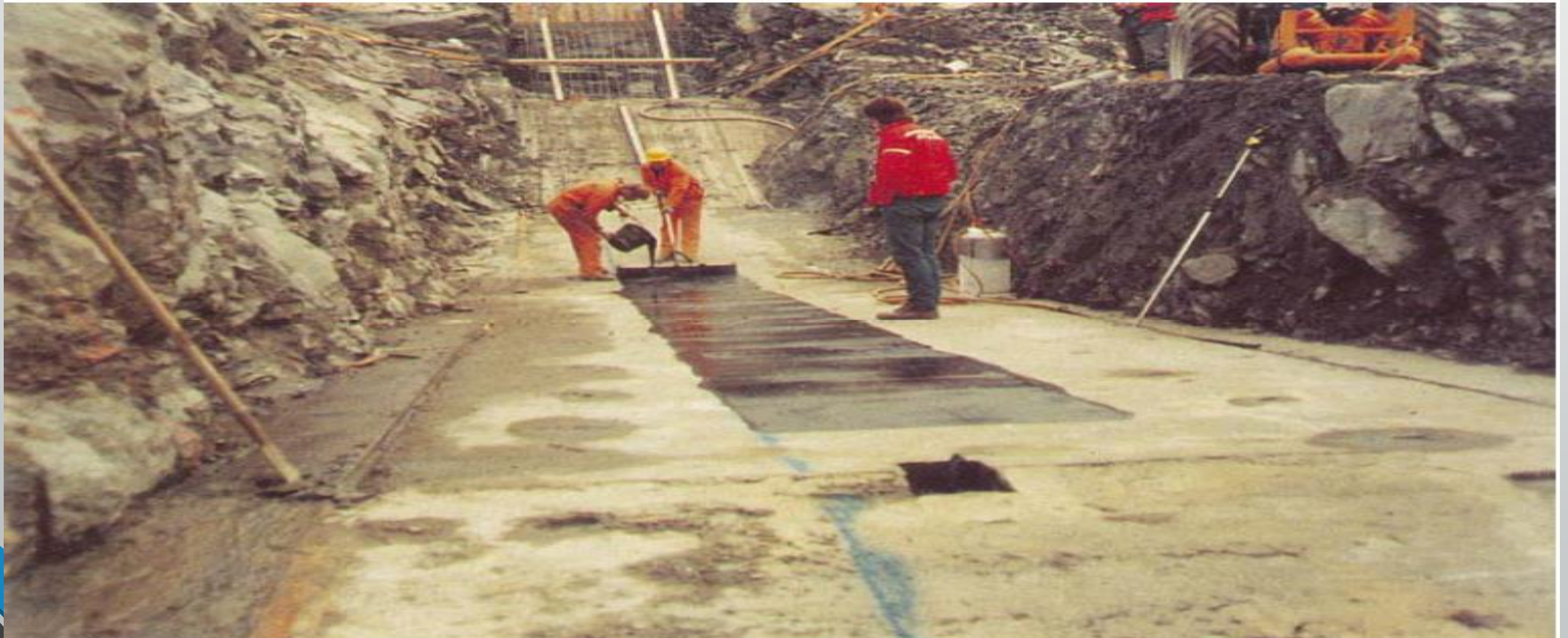
شکل ۷- پخش نمودن ماستیک آسفالت بر روی بتن آب بند کف
