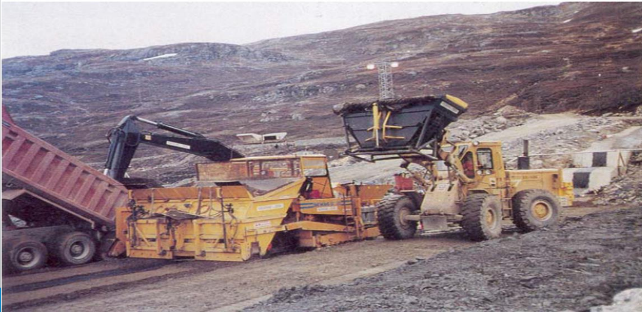
شکل ۵- بارگیری بتن آسفالتی و مصالح فیلتر به دستگاه پخش کننده آسفالت
