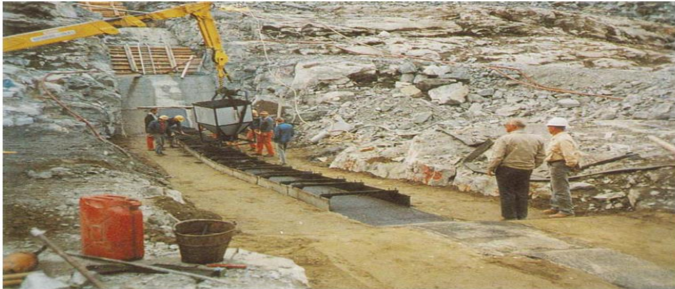
شکل ۶- پخش دستی بتن آسفالتی
