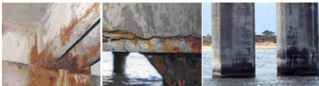
شکل 1- نمونه های از خرابی بر اثر تر و خشکی مکرر
