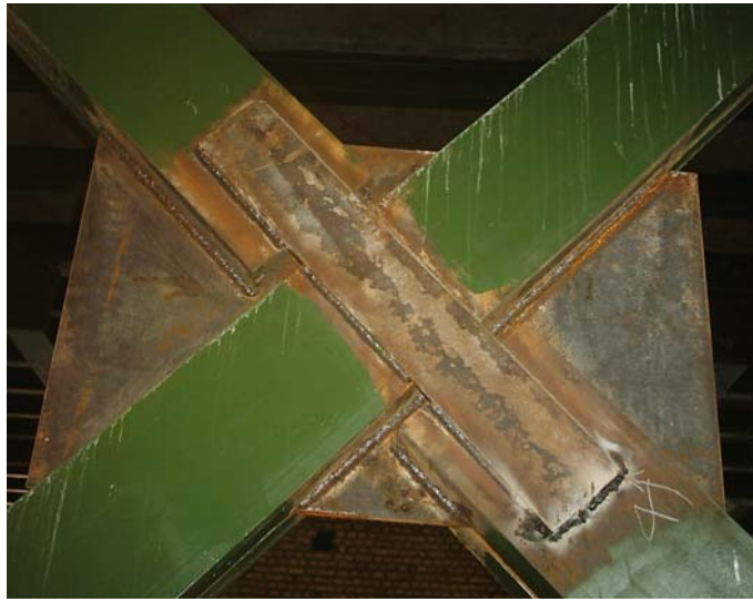
شکل (۱۶-۳) اتصال پیوسته بادبندها در وسط
