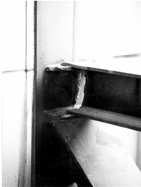
شکل (۶-۱) گسیختگی جوش
